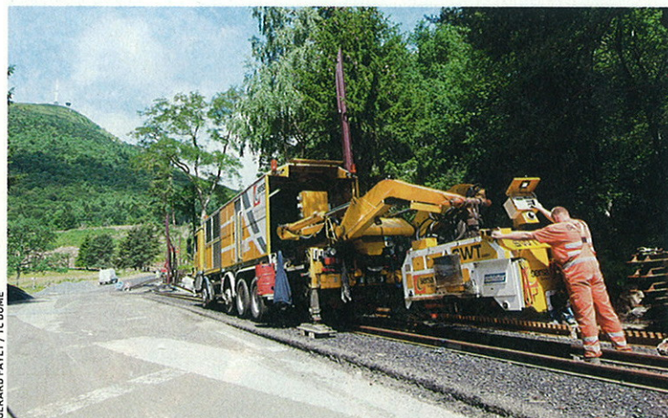
Quinze semaines seront nécessaires pour réaliser la voie d'accès au sommet.
